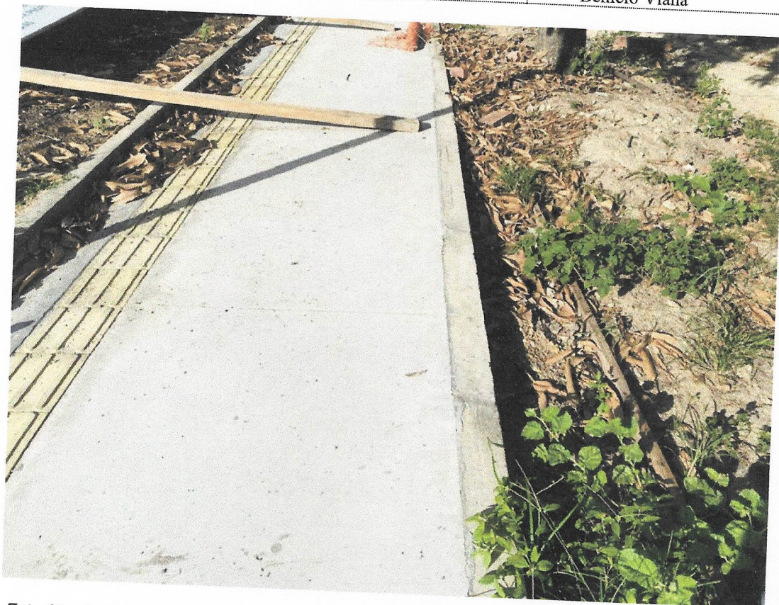
Foto 15 – PISO EM CONCRETO 20 MPA PREPARO MECÂNICO, ESPESSURA 7CM. AF_09/2020
