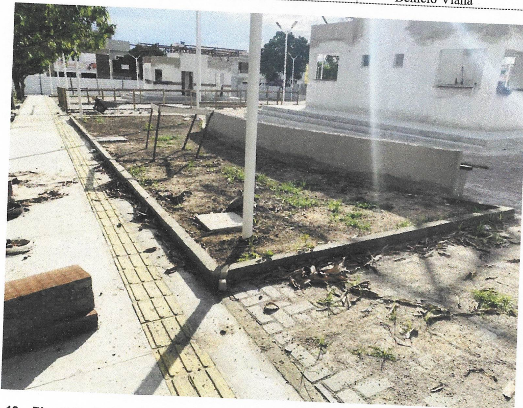
Foto 19 – Piso tátil direcional e de alerta, em concreto colorido, p/deficientes visuais, dimensões 30x30cm, aplicado com argamassa industrializada ac-ii, rejuntado, exclusive regularização de base
