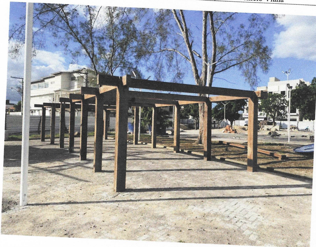
Foto 07- Madeiramento em massaranduba/madeira de lei, peça serrada 10cm x 20cm com abertura de encaixes
