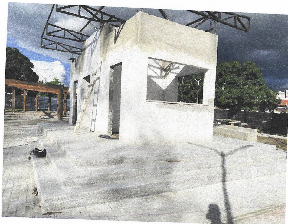
Foto 04 – APLICAÇÃO DE FUNDO SELADOR ACRÍLICO EM PAREDES, UMA DEMÃO. AF_06/2014
