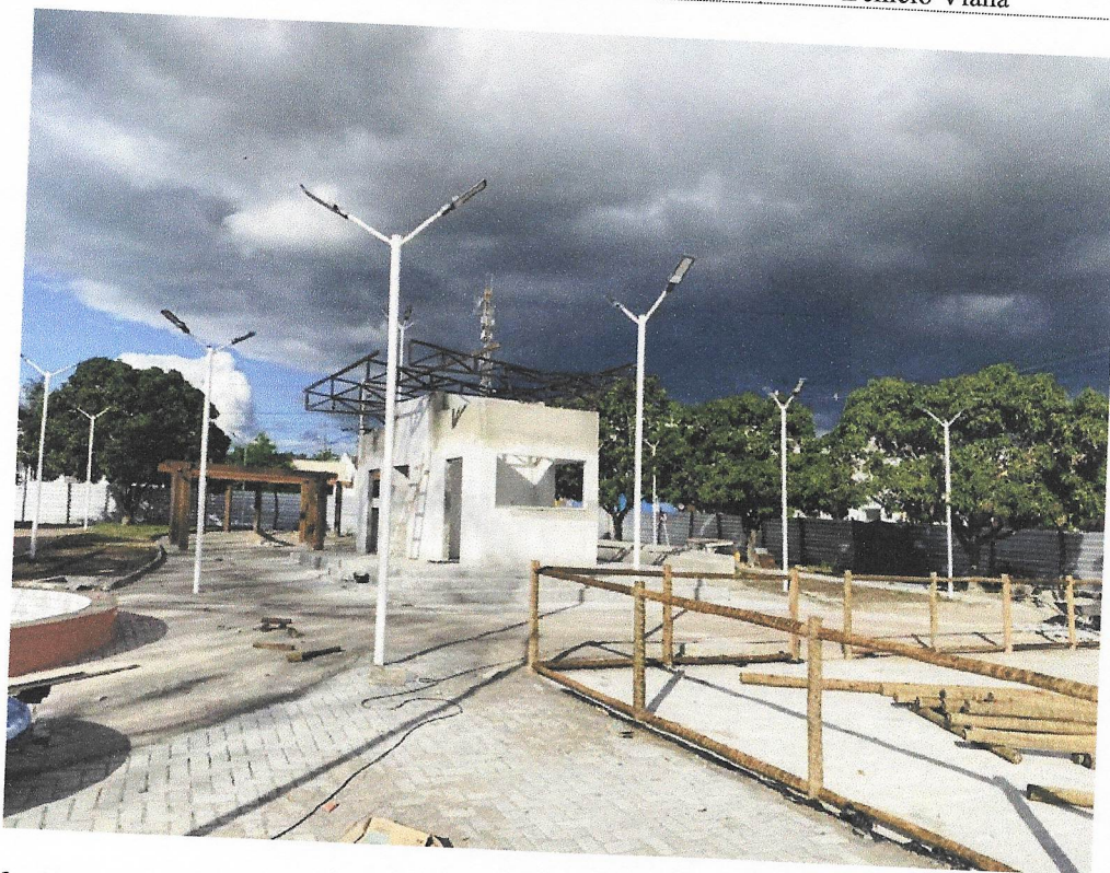
Foto 09 – Poste de aço galvanizado cônico contínuo reto, diâmetro superior 60mm, diâmetro da base 115mm, altura total 5m, Conipost ref. Série 0005/classe 60 da Conipost ou similar
