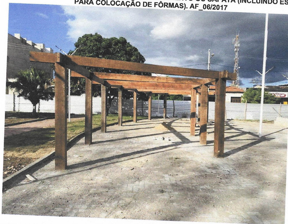
Foto 06- Madeiramento em massaranduba para telhado, peça principal serrada 20cm x20cm, com abertura de encaixes
