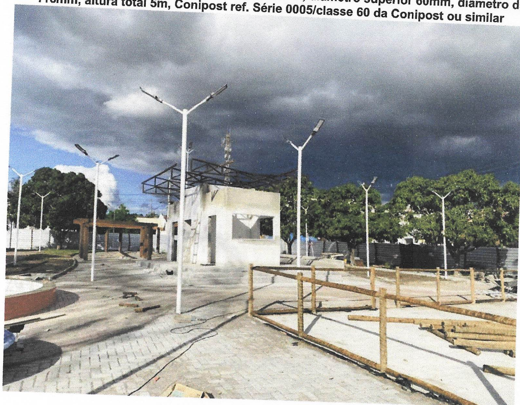
Foto 10 – Luminária em LED para iluminação pública, 30W, bivolt, Selo A Inmetro, corpo em alumínio inj, FP 0,97, prot. DPS 10kv, IP66, IK09, Temp. cor 5000k, IRC= ou 70%, v. útil 50.000h, 120 lm/w.gar.5 anos, modelo GL216 G-light ou similar - Rev 01
