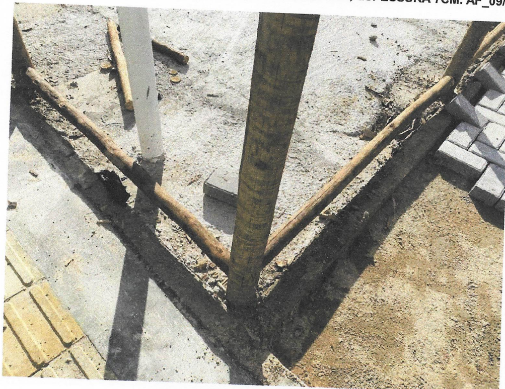
Foto 18 – GUIA (MEIO-FIO) CONCRETO, MOLDADA IN LOCO EM TRECHO RETO COM EXTRUSORA, 13
