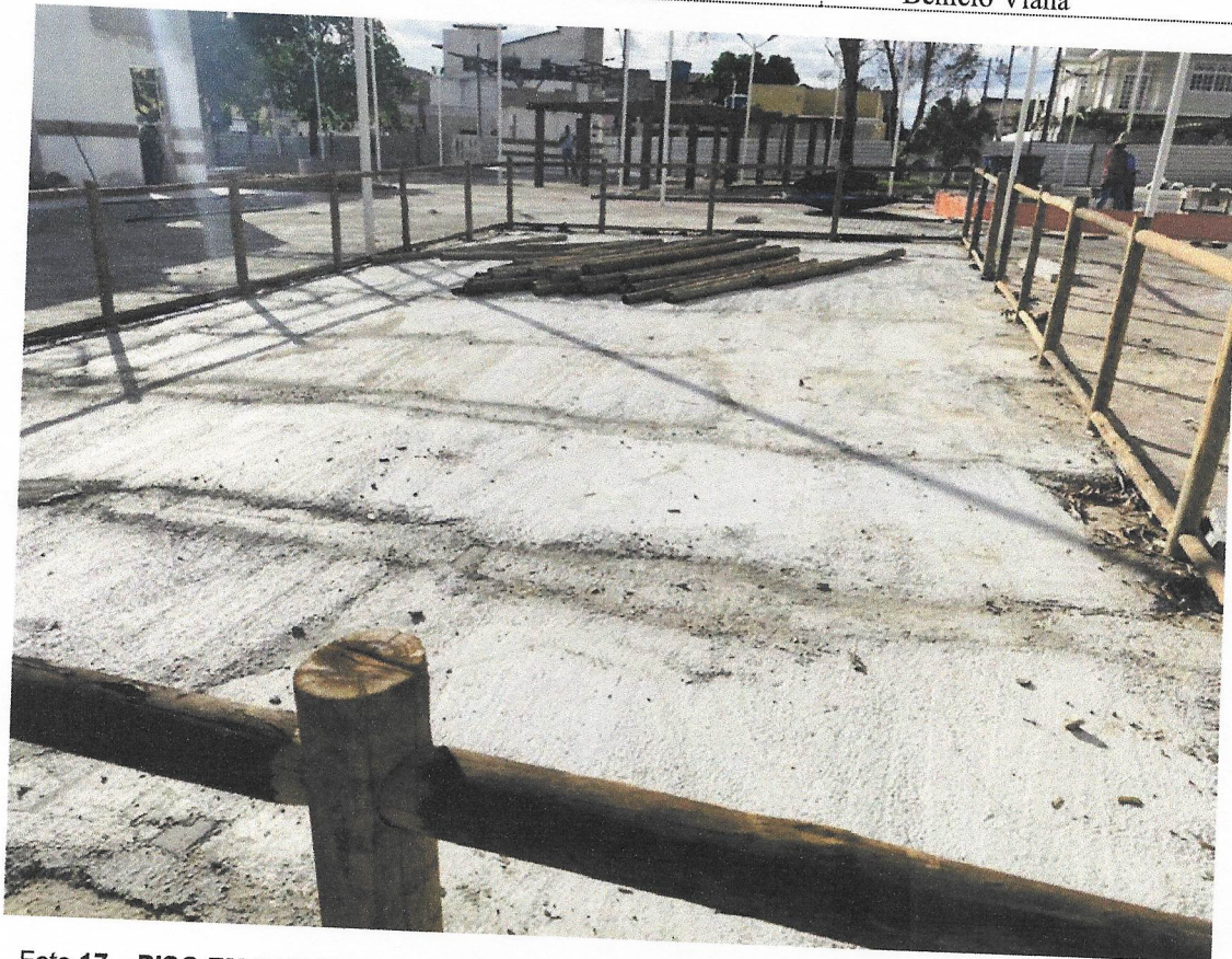
Foto 17 – PISO EM CONCRETO 20 MPA PREPARO MECÂNICO, ESPESSURA 7CM. AF_09/2020
